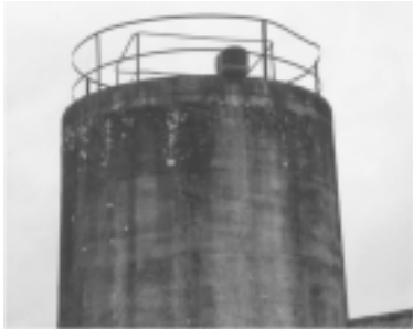
Bild 1: Silo auf dem Hof des Jagdvorstehers Ernst Jude in Hettenhain. 2006 wurde der Nistkasten angebracht und sofort vom Turmfalken angenommen
