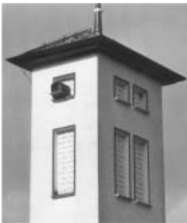
Bild 2: Feuerwachturm Hettenhain. 2006 wurde der Nistkasten angebracht und sofort vom Turmfalken angenommen.
